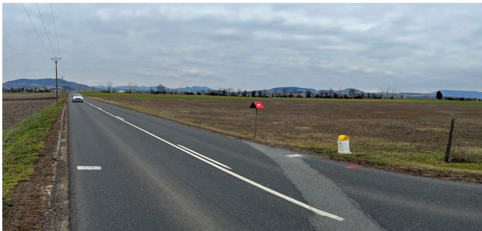
Figure 67 – Vue Nord – site de projet à l'état initial
